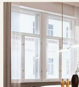
Repliky původních oken materiál dřevo, povrch dveří lak RAL 9003
